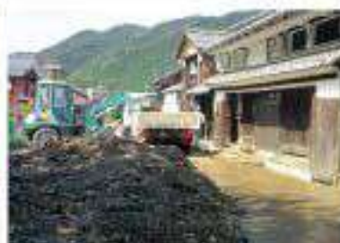
台風18号土砂撤去(平成25年8月)
