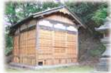
完成(平成21年9月)
