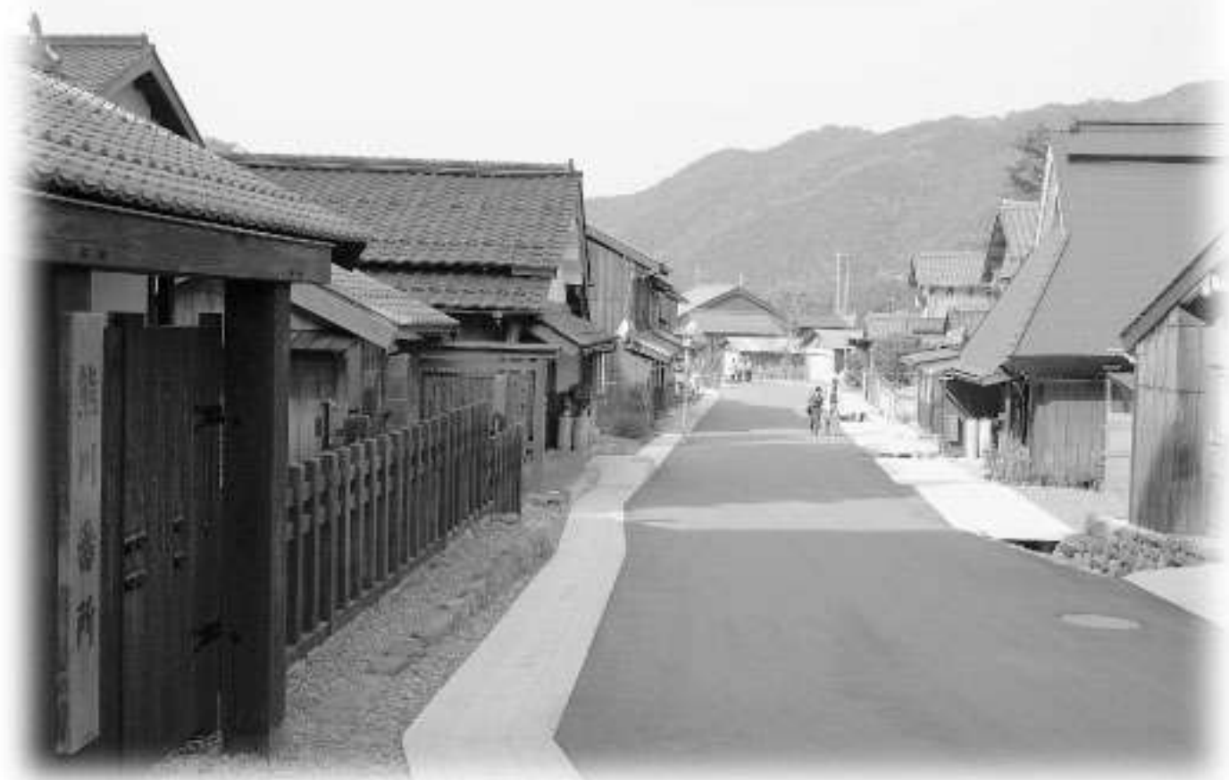
整備が完成した上ノ町の町並み(平成17年11月撮影)
