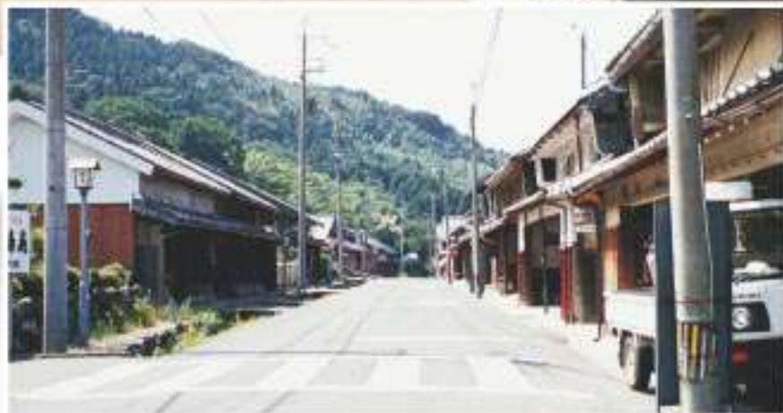
整備前の中ノ町 (平成6年頃)
