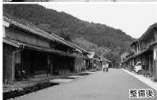
中ノ町の電線地中化、前川などが整備されました。
